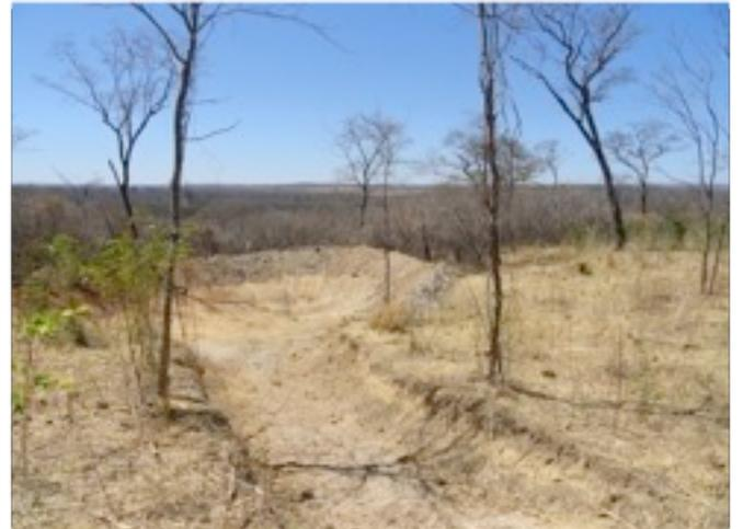
Photo 7 (gauche): Construction de petits barrages pour la rétentions de l'eau (20h de machine à terrasser)
